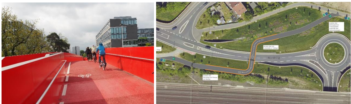
Abbildung 9: Fuß-Radbrücke Rheinstr., Darmstadt (links); Aschaffenburg, Nordring: Skizze Brücke (rechts)
